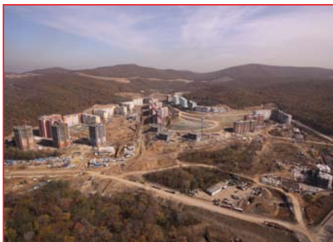
Строительство жилого микрорайона «Снеговая падь» в г. Владивосток
